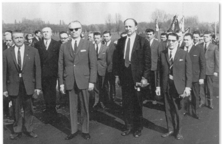
Aanleg en inhuldiging van de nieuwe brug..
